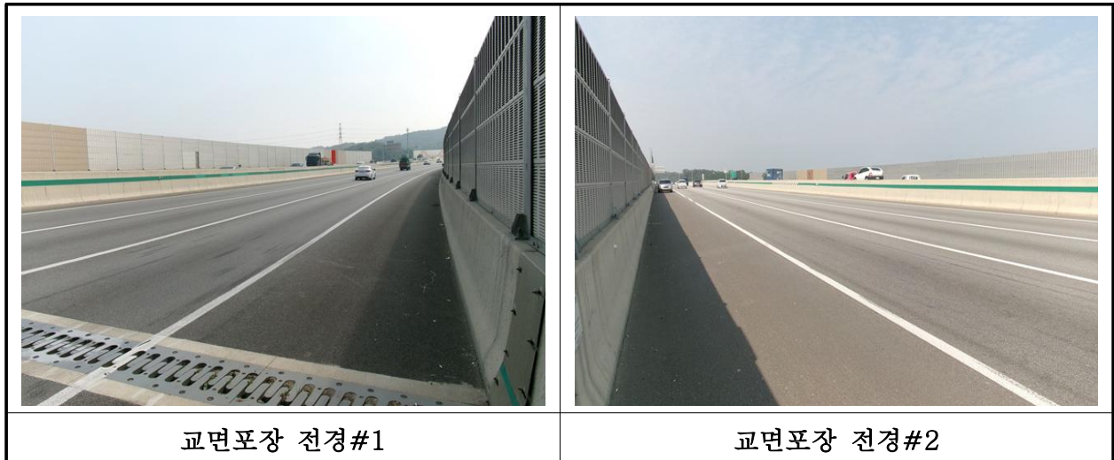
【사진 27.3.19】 교면포장 전경
