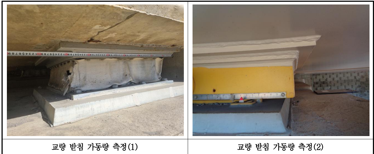
【사진 27.3.15】 교량받침 이동량 측정
