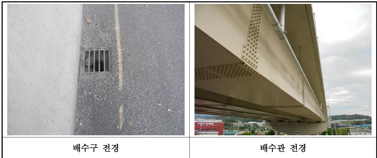
【사진 27.3.21】 배수시설 전경
