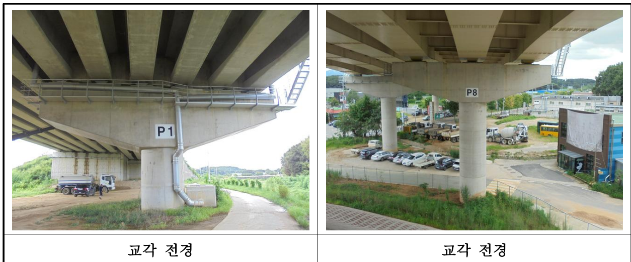
【사진 27.3.10】 교각 전경
