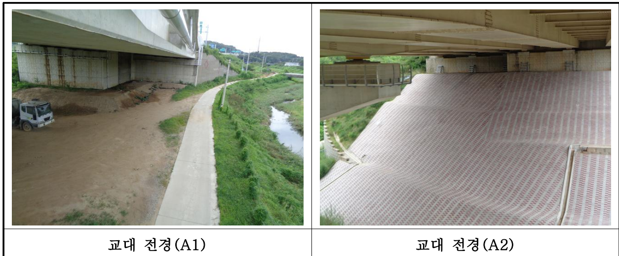
【사진 27.3.8】 교대 전경
