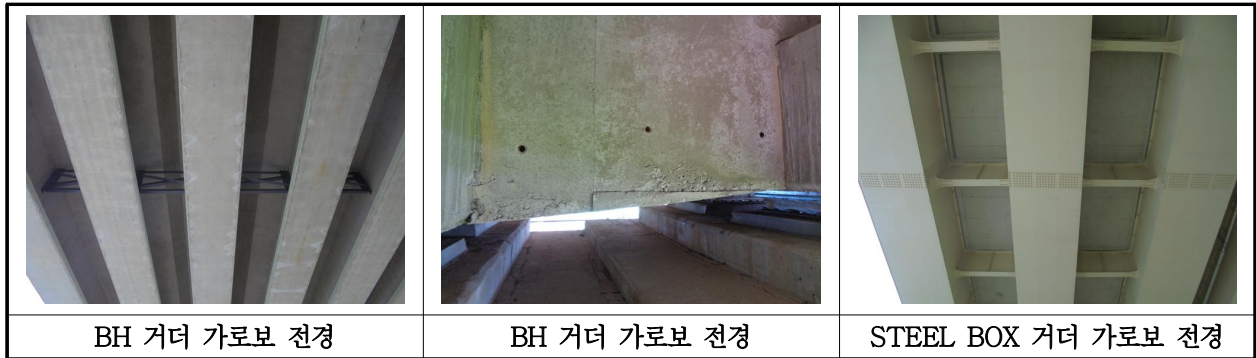
【사진 27.3.6】 가로보 전경
