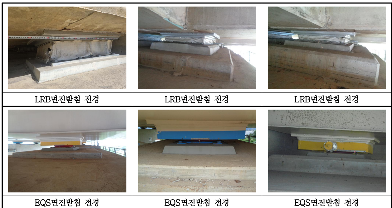
【사진 27.3.12】 교량반침 전경
