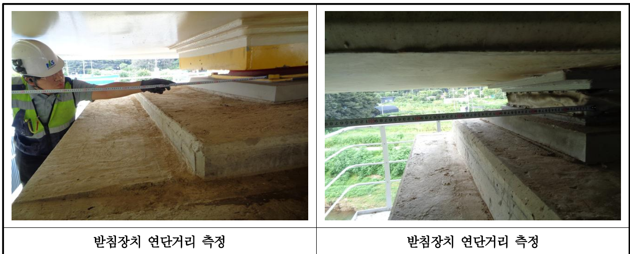
【사진 27.3.14】 교량받침장치 연단거리측정
