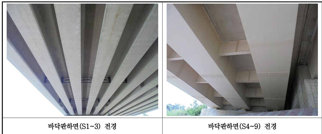
【사진 27.3.2】 바닥판하면 전경
