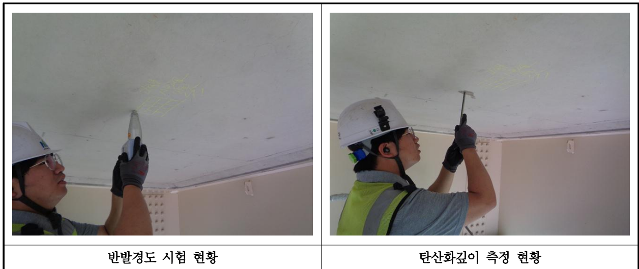
【사진 27.4.1】 콘크리트 내구성조사 현황
