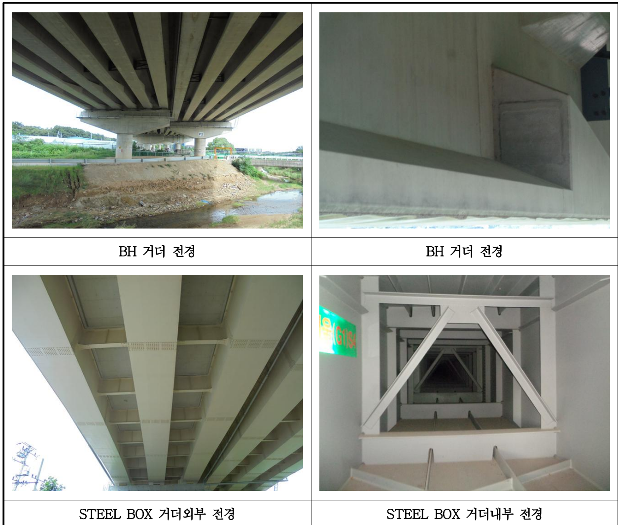
【사진 27.3.4】 거더 전경
